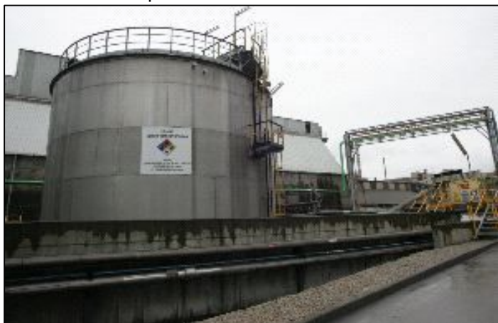
Tanque de oleum en S. Juan de Nieva (AZSA)
