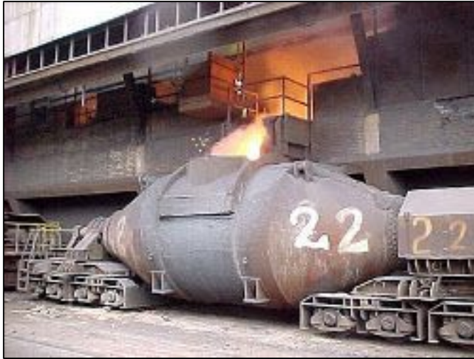
Torpedo usado para transportar el arrabio a las acerías
